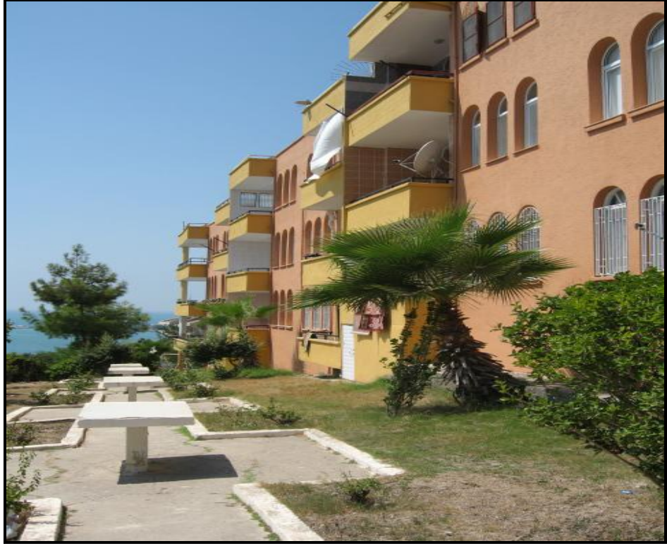
řekil 4.38. Arařtırma Alanındaki Falez Yapısının BulunduĖu Blgedeki İkinci Konutlar (Orijinal, 2007)
