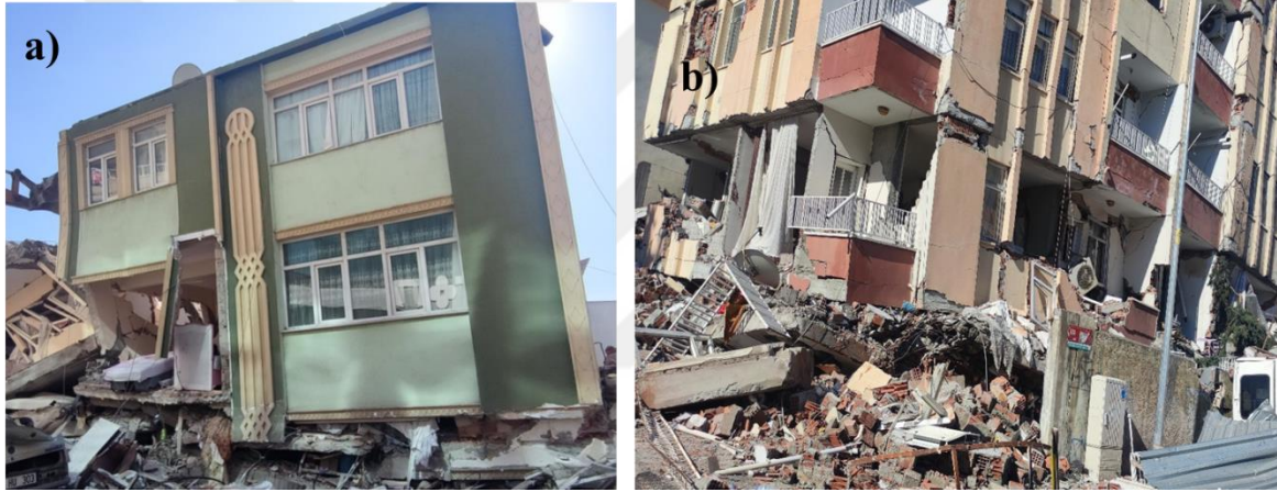
Resim 1.1. 6 Şubat 2023 depremlerinde Adıyaman merkezde yumuşak kat mekanizmasından dolayı göçen betonarme binalar
