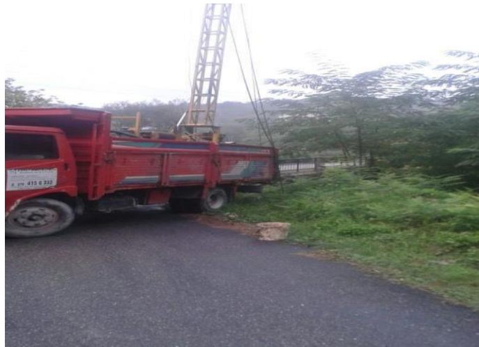
Şekil 3.9 Sondaj Çalışması SK 2.
