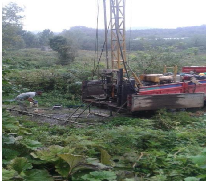
Şekil 3.8 Sondaj Çalışması SK 1.
