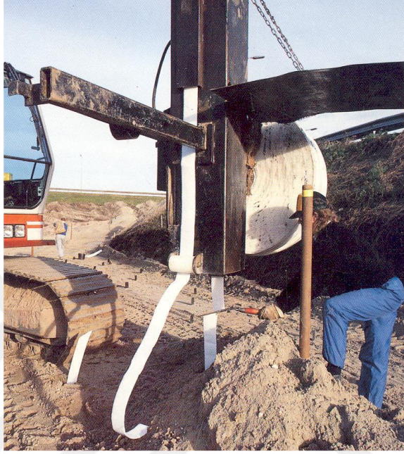
Şekil 2.13. Yapay dren uygulama örneği
