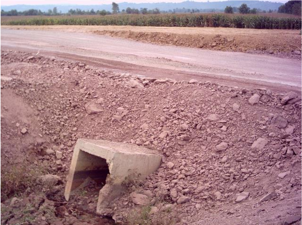
Şekil 1.1. Yol dolgusu altında meydana gelen oturmalar
