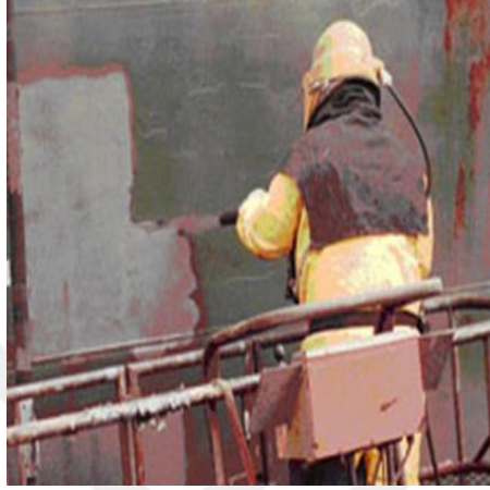
řekil 2.12 Gemi Karinasının Kum Raspası Yapılması (Kiřisel Arřiv)
