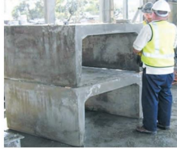
Şekil 1.10. Prekast geopolimer kutu menfez (Glasby vd., 2014)
