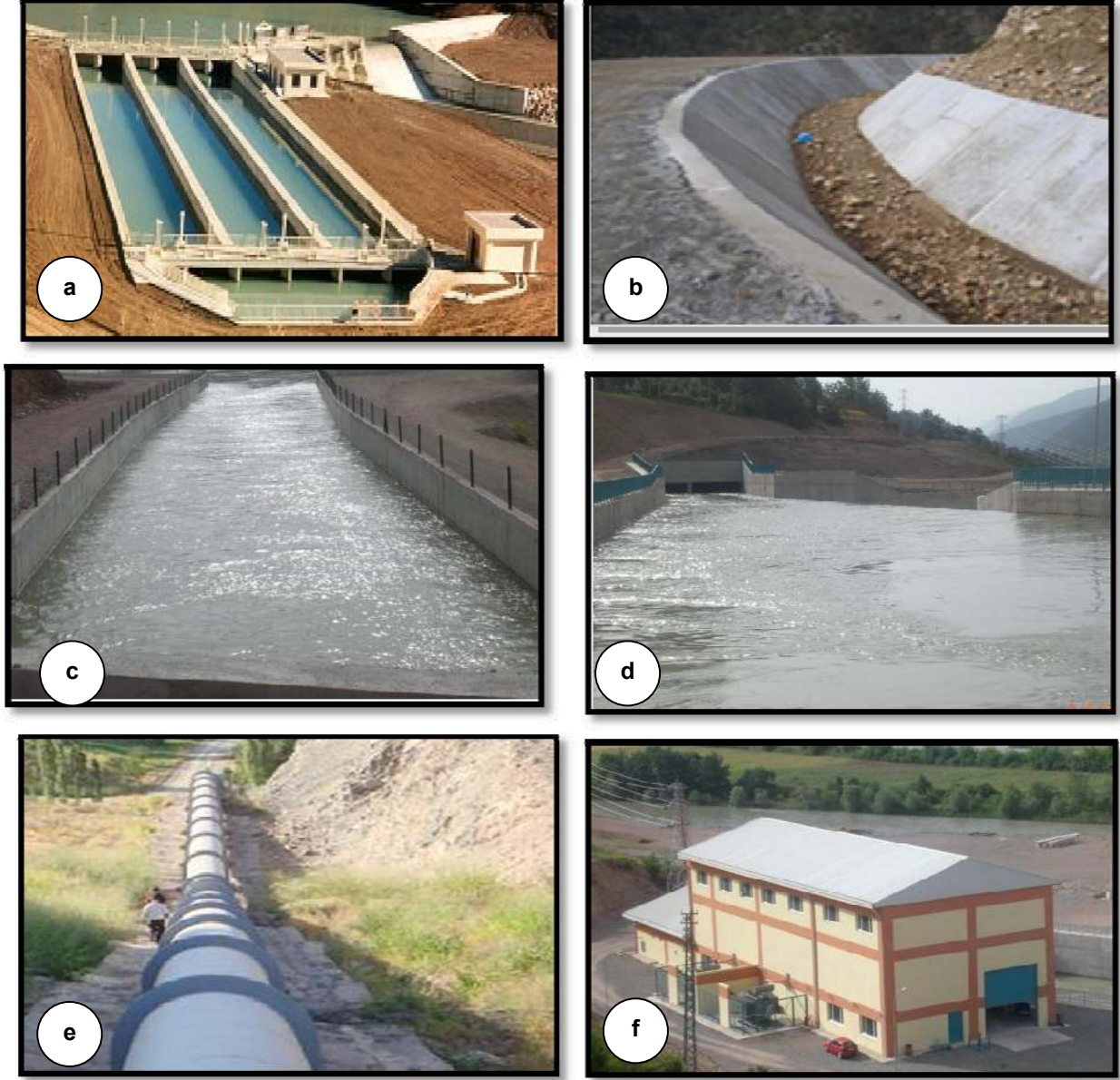
Şekil 1.1.Hidroelektrik Santrallerinin ana elemanlarıregülatör (a) iletim kanalı (b), çökeltimhavuzu (c), yükleme havuzu (d), cebri boru (e) ve santral binası (f)
