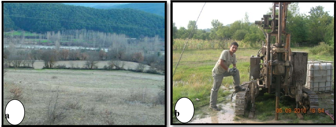
Şekil 3.12. (a )Santral binası alanı(b) ve santral alanında açılan sondajlar (kot: 562 m)
