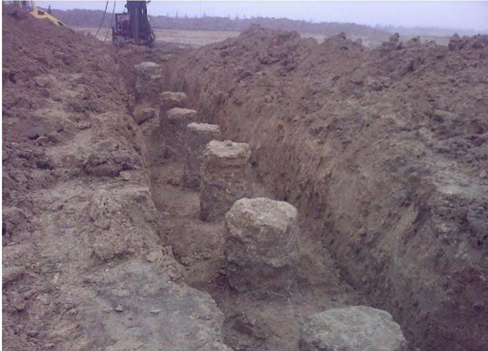
Şekil 2.47 Çap kontrolü yapılan bir jet enjeksiyon uygulaması
