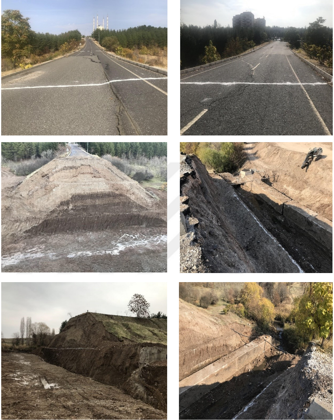
Şekil 3.3 Yolun durumunun arazideki görünümü
