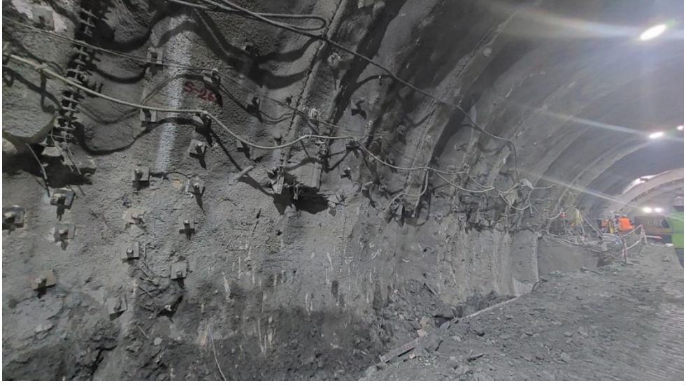
Şekil 4.8. NATM ile açılan tünelin alt yarı bölgesine geçici tahkimat işlemine başlamadan önce
