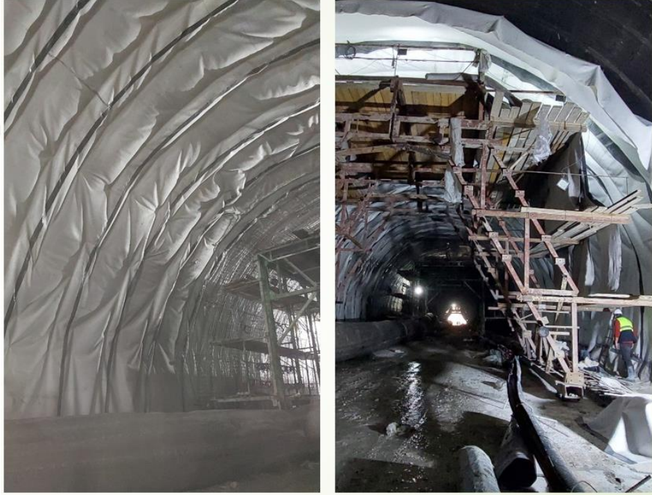
Şekil 4.13. NATM ile açılan tünelde kalıcı destek sistemi olarak nihai beton kaplama uygulaması
