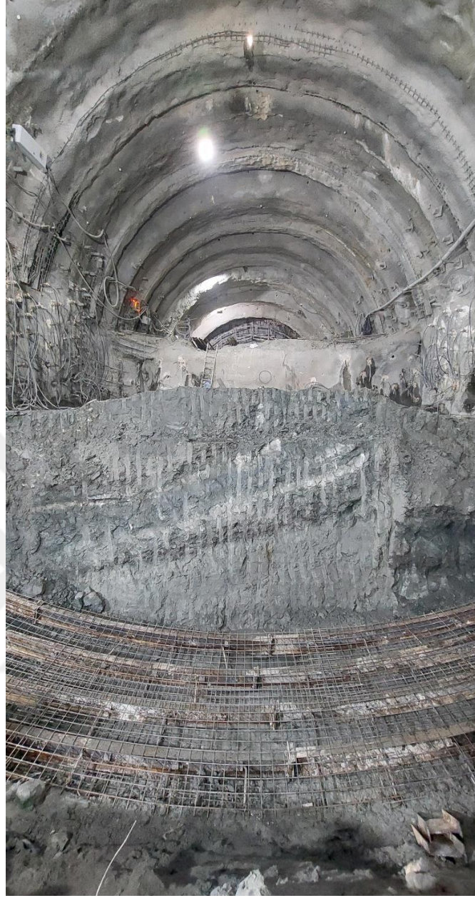
Şekil 4.7. NATM yöntemi ile üst yarı, alt yarı ve taban kazılarına karşıdan bakış
