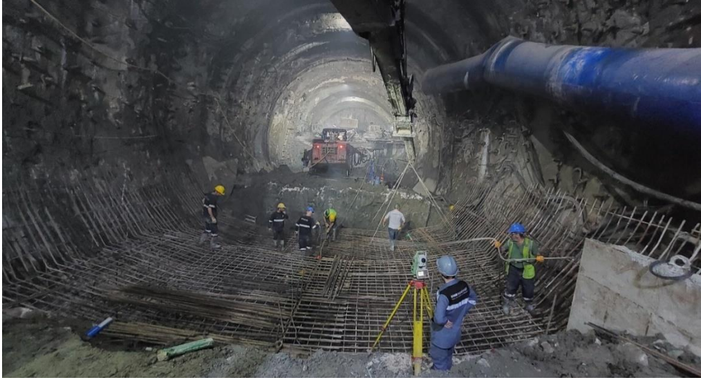
Şekil 4.9. NATM ile açılan tünelin taban kazısı ardından taban donatısı yerleştirilmesi aşaması
