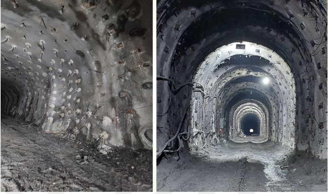
Şekil 4.12. NATM ile açılan tünel iç çeperine zemin iyileştirme ve püskürtme beton uygulaması
