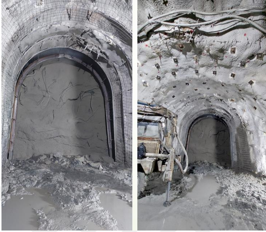
Şekil 4.10. Tünel ayna çerçevesinde üst yarı bölgesine geçici tahkimat için destek elemanlarının yerleştirilmesi
