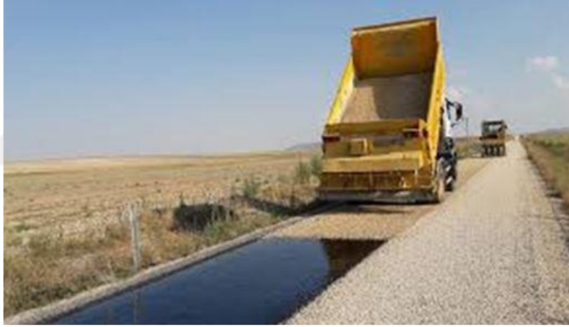
Şekil 3.3: Yüzeysel kaplama saha uygulaması [30].
