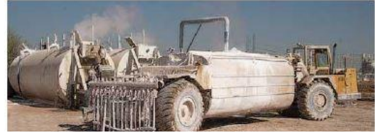
b-Karışımın dağıtıcıya aktarılması
