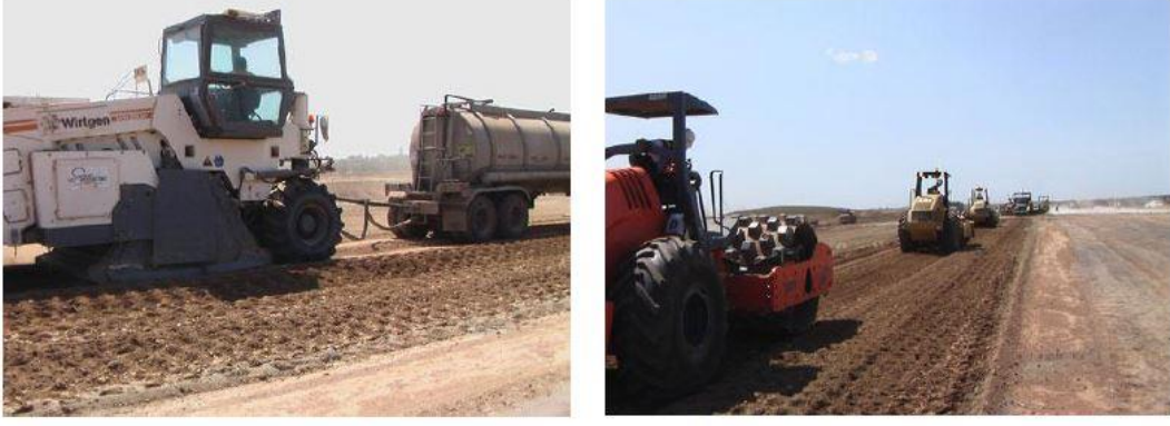
Şekil 2.10: Çimento ile zemin stabilizasyonu [17].
