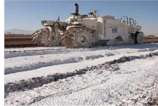
d-Kirecin zemine karıştırılması
