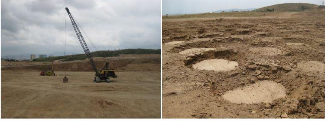
Şekil 2.8: Dinamik kompaksiyonun saha uygulaması [11].
