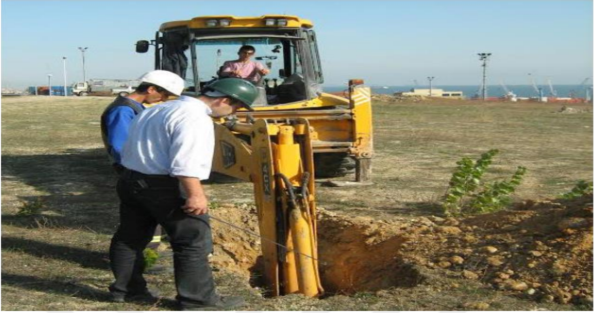
Şekil 1.4. Araştırma çukuru açılması
