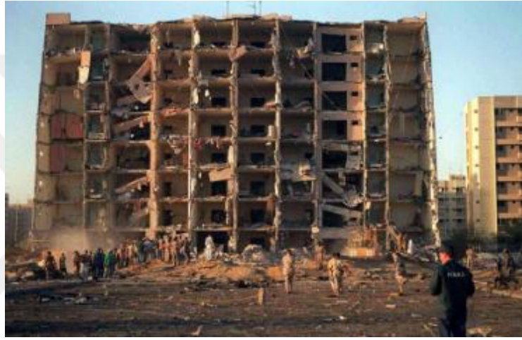
Şekil 4. Terör saldırısı sonrası Khobar Towers (Shams-AL, 2012)
