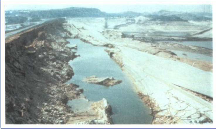
Resim 2. 4. 1971 depreminden sonra The Lower San Fernando Barajında oluşan akma göçmesi (Mollamahmutoğlu ve Babuçcu, 2006).
