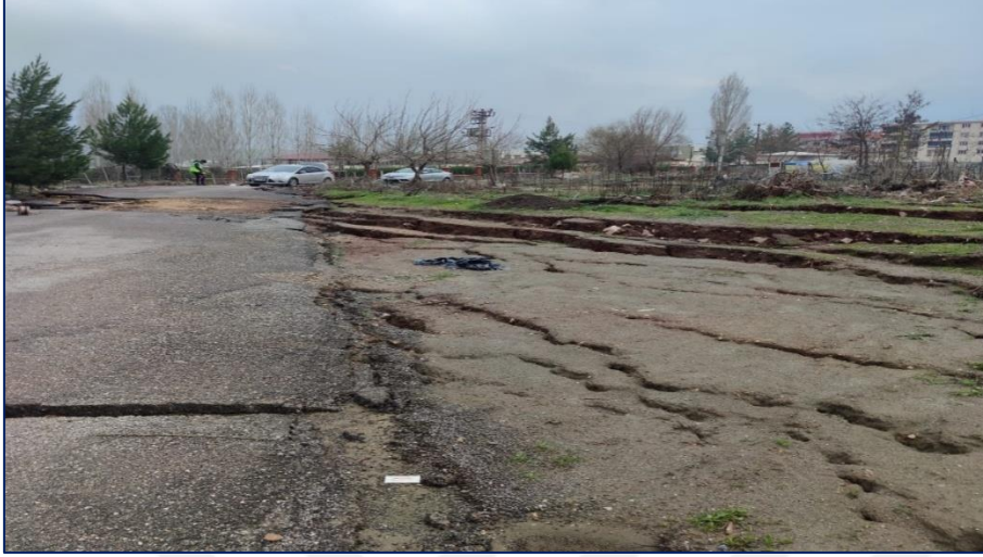
Resim 2. 5. 6 Şubat 2023 Kahramanmaraş-Pazarcık ( M_w= 7.7 ) ve Elbistan ( M_w= 7.6 ) depremleri ardından Adıyaman Gölbaşı ilçesinde gözlemlenen yanal yayılma ve sıvılaşma görüntüsü
