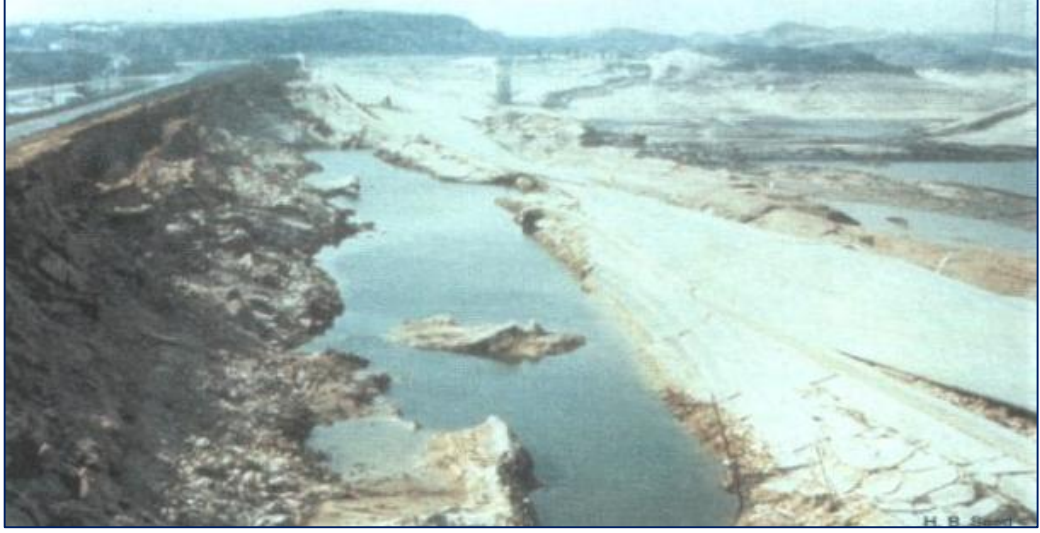
Şekil 3.8. 1971 depreminde The Lower San Fernando barajında oluşan akma (Mollamahmutoğlu ve Babuçcu, 2006)
