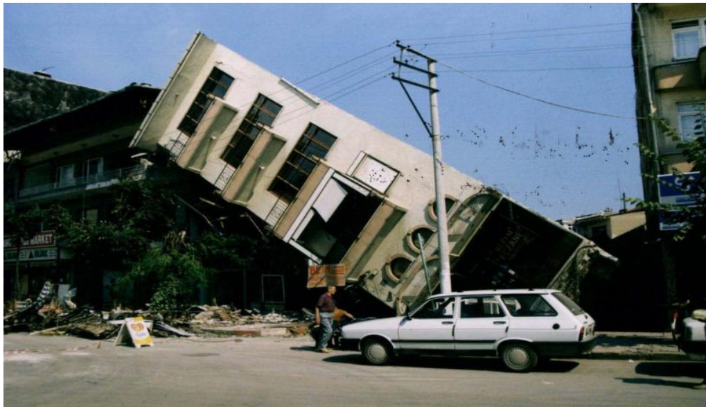
Şekil 3.13. 1999 Türkiye depreminde Adapazarı ilinde sıvılaşma sonucu devrilen binalar ( http://www.jeofizik.org.tr/resimler/ekler/d50601b7bc18501_ek.pdf )
