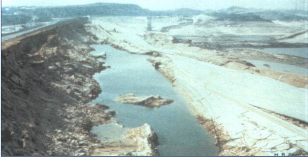
Şekil 3.8. 1971 depreminde The Lower San Fernando barajında oluşan akma göçmesi (Mollamahmutoğlu ve Babuçcu, 2006)
