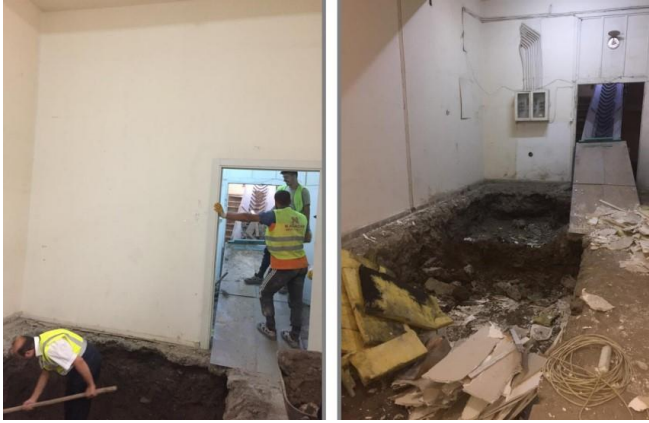
Şekil 5.70. Uygulama sırasında muhdes duvar ve kapının kaldırılması [75].
