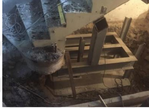
Şekil 5.57. M-04 Merdiveni Kazı Sırasında Güçlendirilmesi İçin Uygulanan Askıya Alma İşlemi [75].
