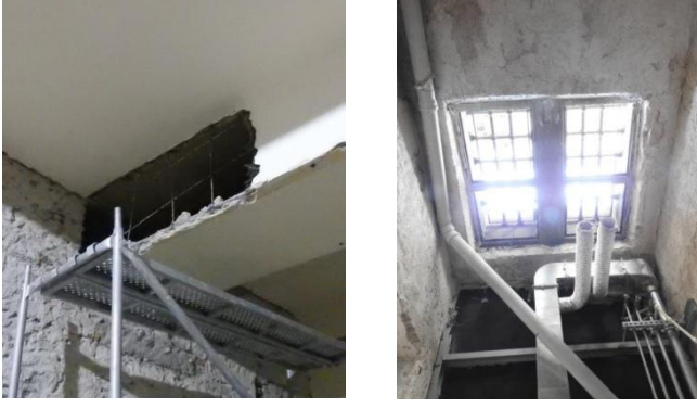
Şekil 5.69. Bodrum Kat Açığa Çıkan Özgün Havalandırma Kanalı / Bodrum Kat Sıhhi Tesisat Borularının Uygulanması [75].
