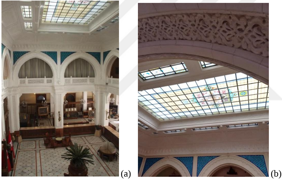
Şekil 5.21. Işığı Katlar Boyunca İleten Aydınlık Vitrayı (a) [75] (b) (Gizem Demiran).
