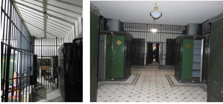
Şekil 5.36. B-36 ve B-38 Mekanı Karo Mozaiklerin Temizlenmesi [75].
