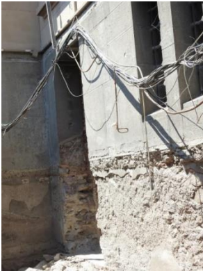
Şekil 5.62. Bağlantı Koridoru İçin Pencere Boşluklarının Açılması / Döşemenin Yapım Aşaması [75].
