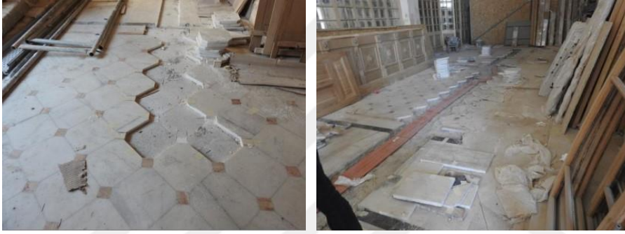
Şekil 5.40. Z-23 A-J Mermer Malzemenin Çatlak Onarım Çalışmaları [75].
