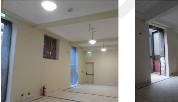
Şekil 5.50. B-06 Kapı Boşluğu Olarak Dönüştürülen Açıklıklar [75].
