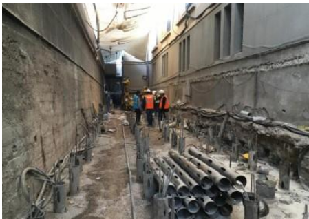
Şekil 5.67. Batı Cephesinde Mini Kazık Çalışmaları / Radye Temel Yapılması [75].
