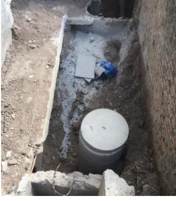
Şekil 5.60. Güney Cephesinde Merdiven Yıkıldıktan Sonra Ortaya Çıkan Özgün Tesisat Galerisi [75].
