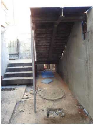
Şekil 5.61. Güney Cephesinde Yemekhaneye Ulaşan Yeni Merdiven Yapılması [75].
