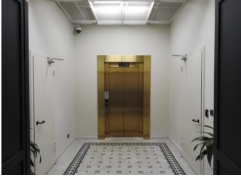
Şekil 5.73. B-05 Mahalli Mekânda Yeni Bir Dolaşım Elemanı Olan Asansör Boşluğunun Açılması / Uygulama Sonrası Asansör [75].
