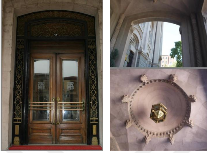
Şekil 5.28. Doğu Cephesi Ana Giriş Kapısı- Detayları [75].
