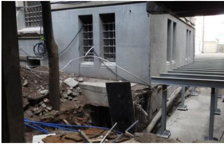
Şekil 5.66. Tarihi Yapının Kuzey Cephesinde ki Batı Kısmının Kazılarak Özgün Tesisat Sisteminin Açığa Çıkarılması [75].
