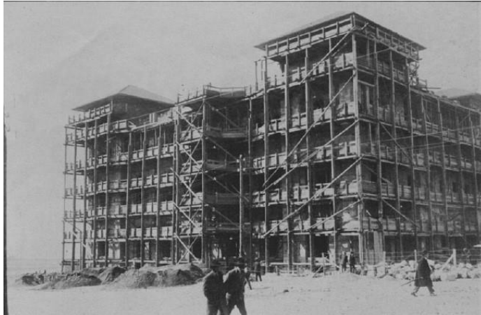
Şekil 5.9. Tarihi Genel Müdürlük Binası İnşaat Aşaması-Aralık,1927 [74].
