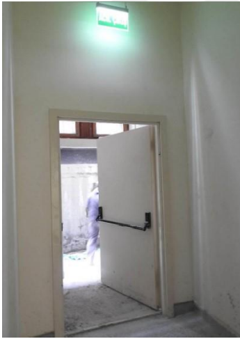
Şekil 5.76. B-25 Yangın Kaçış Koridoru Mekânı [75].
