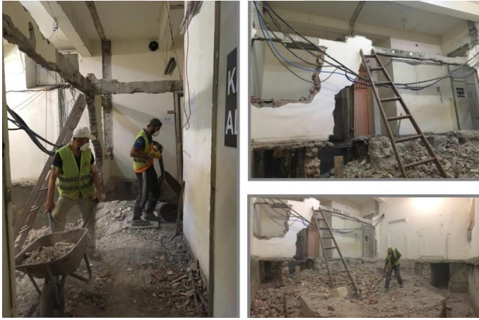
Şekil 5.74. Mekânları Bölen Muhdes Duvarların Kaldırılması [75].
