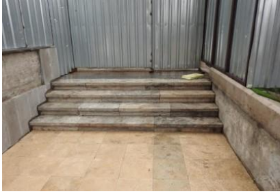
Şekil 5.65. Doğu Cephesi Kuzeydeki Yürüyüş Yoluna Bağlantıyı Sağlamak İçin Basamakların Yapılması [75].
