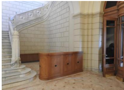
Şekil 5.39. Z-19 Mermer Kaplamaların Temizlenmesi [75].
