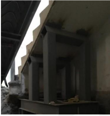
Şekil 5.57. M-04 Merdiveni Kazı Sırasında Güçlendirilmesi İçin Uygulanan Askıya Alma İşlemi [75].
