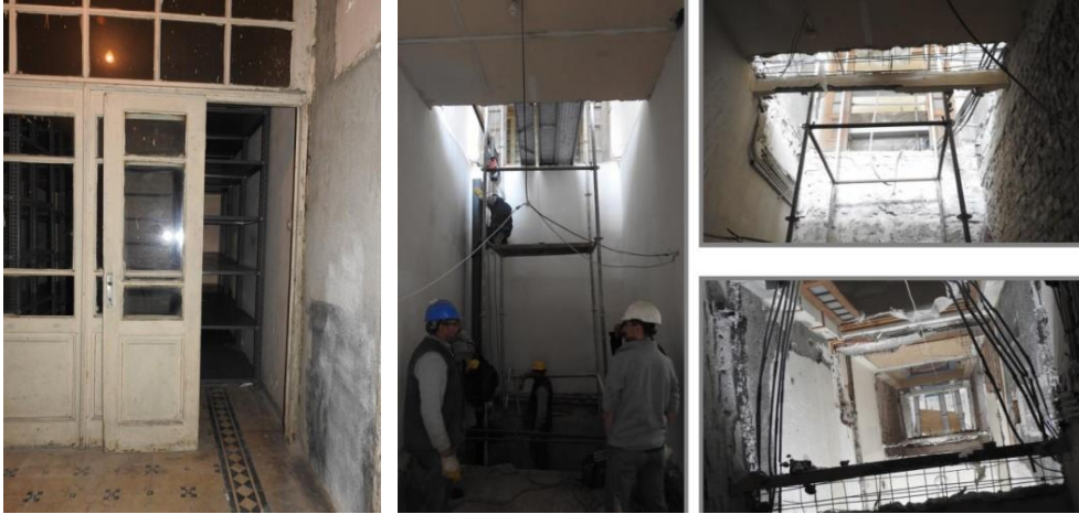
Şekil 5.72. B-05 Mahalli Mekânda Camlı Kapının ve Duvarın Kaldırılması [75].
