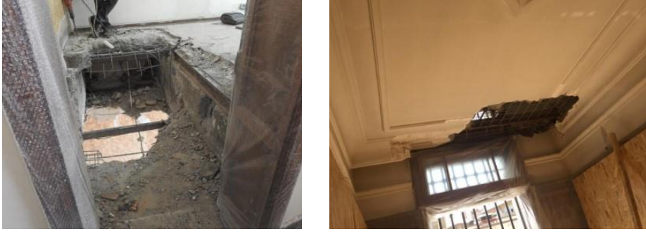
Şekil 5.77. Z-16 Mekânı İçerisinde Ortaya Çıkan Eski Asansör Boşluğu [75].
