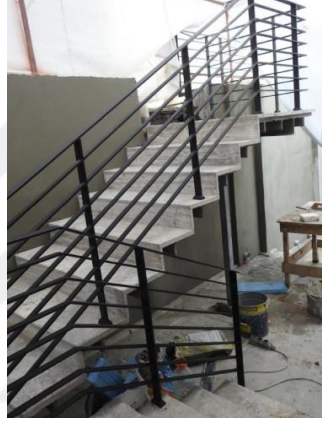
Şekil 5.61. Güney Cephesinde Yemekhaneye Ulaşan Yeni Merdiven Yapılması [75].
