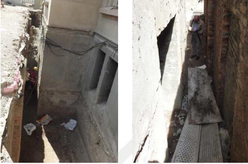
Şekil 5.58. Güney Cephesinde B-05 mahallinde bulunan kapı önündeki dolgunun kaldırılması [75].
