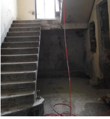
Şekil 5.56. B-01 Mekânına Ait M-04 Merdiveni [75].
