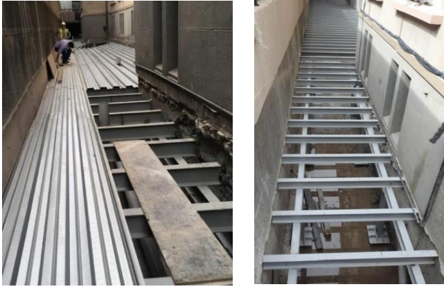
Şekil 5.68. Batı Cephesinde Dolgu Kotunda Çelik Platform Yapılması [75].
