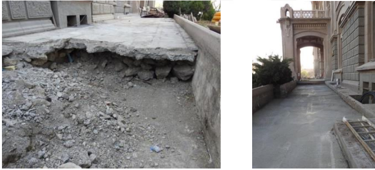
Şekil 5.64. Özgün Zemin Kotunun Açığa Çıkartılması / Özgün Zemin Kotuna Yeni Döşeme Yapılması [75].
