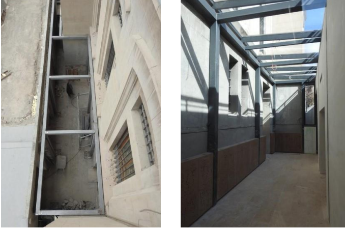
Şekil 5.63. Bağlantının Sağlanması İçin Oluşturulan Müze Holünde Çelik Konstrüksiyon Malzeme Kullanımı [75].
