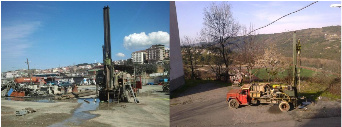
Şekil 4.1 Sondaj Çalışmalarından Görünüm.
