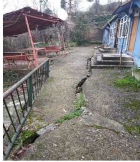
Şekil 7.4a Heyelan kesiti için yüzeyde gözlenen yapısal hasarlar 2012-2018
